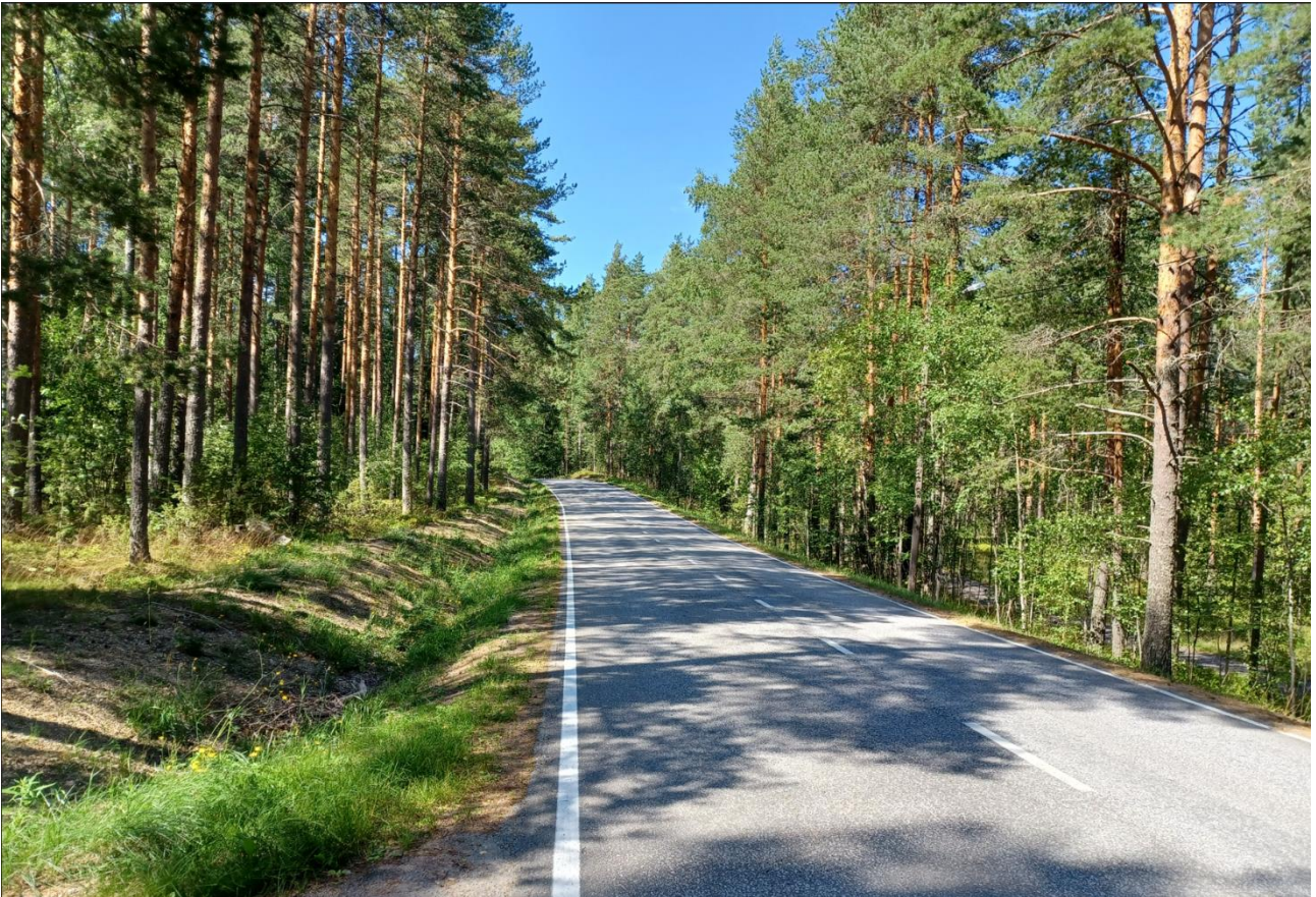
Kuva 15. Tiuruniementie kuvattuna suunnittelualueen kohdalta luoteeseen. Kuvan vasemmassa reunassa, puiden takana näkyy kevyen liikenteen väylä, joka on muutamia metrejä alempana kuin Tiuruniementie
